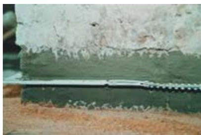
Si provvede ad isolare le due parti di muro sezionate inserendo una barriera continua di materiali anticapillarità (quali manti bituminosi, laminati plastici o in vetroresina) che blocca l'umidità sotto il livello del taglio.
