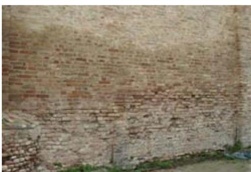
Ogni parete ed ogni strato di intonaco contengono, dopo il prosciugamento, una certa quantità di sali igroscopici (che attraggono umidità) propri della struttura muraria perchè composta da materiali porosi, ma anche sali estranei ad essa (per esempio i sali del terreno).
