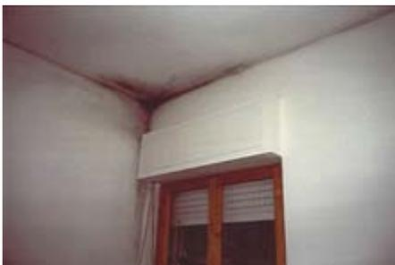
Quando viene alterato un tale ottimale equilibrio tra umidità, temperatura e ricambio d'aria naturale, si presenta l'insorgere di fenomeni che causano la cosiddetta condensa superficiale. La presenza di piccole macchie di muffa sulle pareti, aloni neri (muffe nere) negli spigoli e nei vertici del soffitto o le gocce d'acqua di condensa che si formano sui vetri sono un segnale che il problema esiste e necessita di interventi rapidi.
