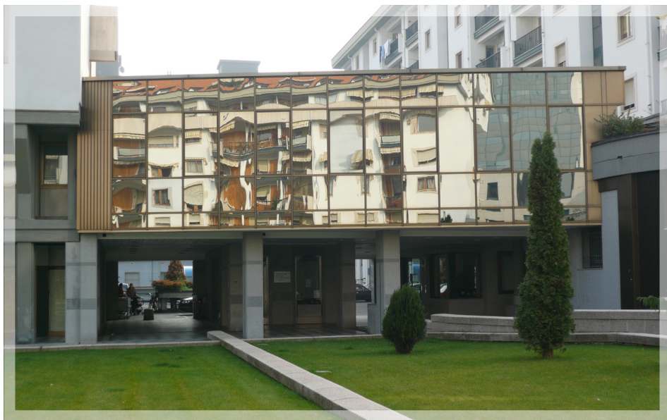
La vetrata della sede del Collegio dei Geometri e G.L. della Provincia di Cuneo, in Cuneo via Luigi Einaudi n. 20
